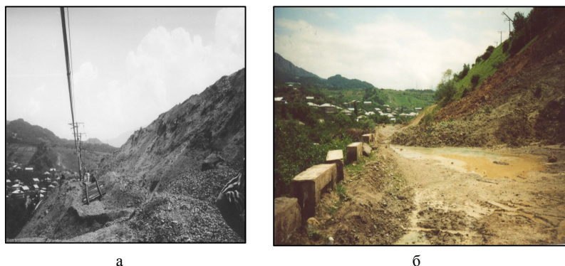
Рис. 2. Разрушенная оползнем железная дорога (а) и обходная автомобильная дорога (б) (фото В.Р. Бойнагряна).
