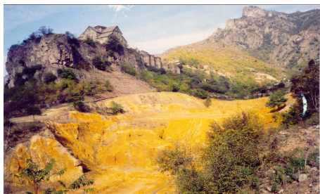
Рис. 1. Фрагмент разрушения “пляжной” зоны медно-молибденового законсервированного хвостохранилища.
