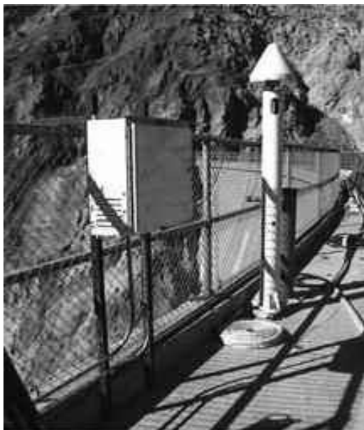
Рис. 2. Стационарная базовая станция спутникового приемника GNSS.
