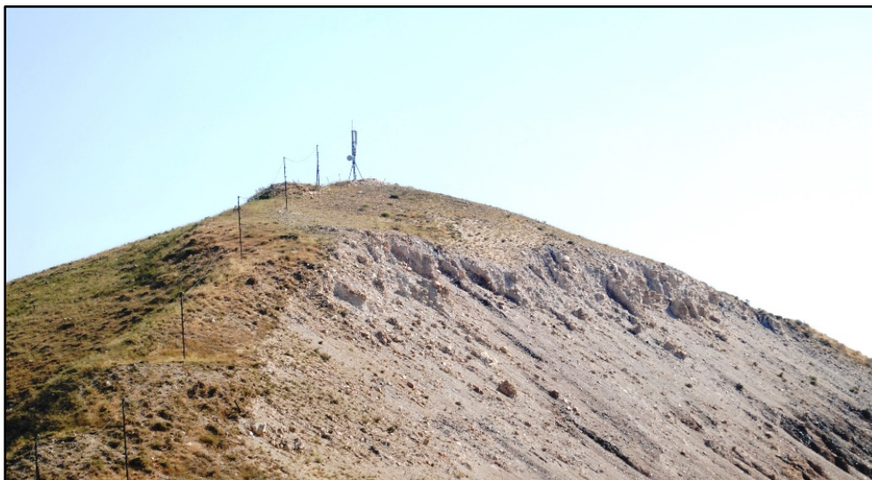
Рис. 3. Разрушение склона, сложенного перлитами.
