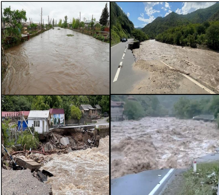
Рис. 4. Поднявшийся уровень воды в р. Дебед и размыв полотна автомобильной дороги.
